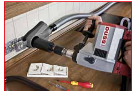
Sauberes Nassbohren in Beton mit DUSS Absauglocke, handgeführt
