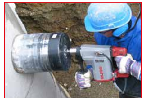
Anbohren von Betonschacht – nass, handgeführt
