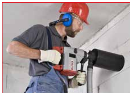
Trockenbohren in Mauerwerk mit Staubabsaugung, handgeführt
