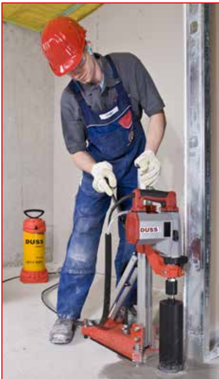
Nassbohren in Beton, ständergeführt
