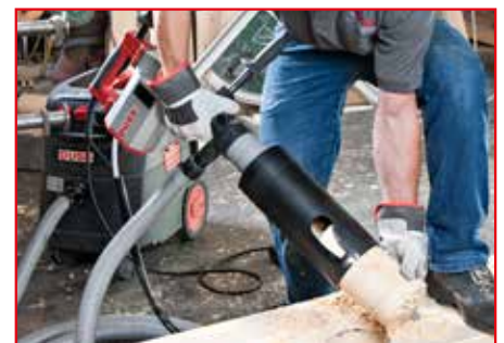
Bohren in Holz mit Staubabsaugung – handgeführt
