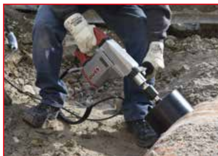
Anbohren von Kunststoffrohr – trocken, handgeführt
