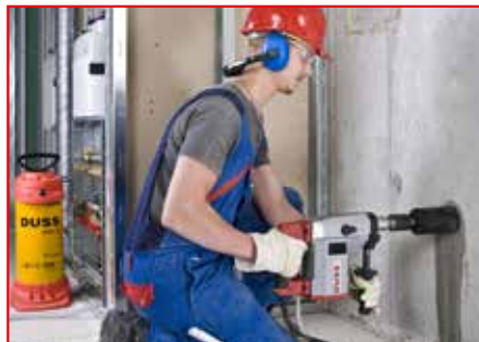
Dosensenken in Beton – nass, handgeführt
